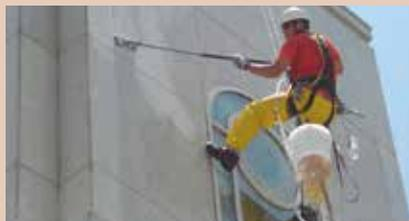
Foto ilustrativa do procedimento de limpeza de fachadas. Aplicar esguicho suave de água (para não danificar rejuntas e dilatações), limpar com esponja macia ou pano macio e sabão neutro, depois esguichar suavemente água para remover o sabão.
